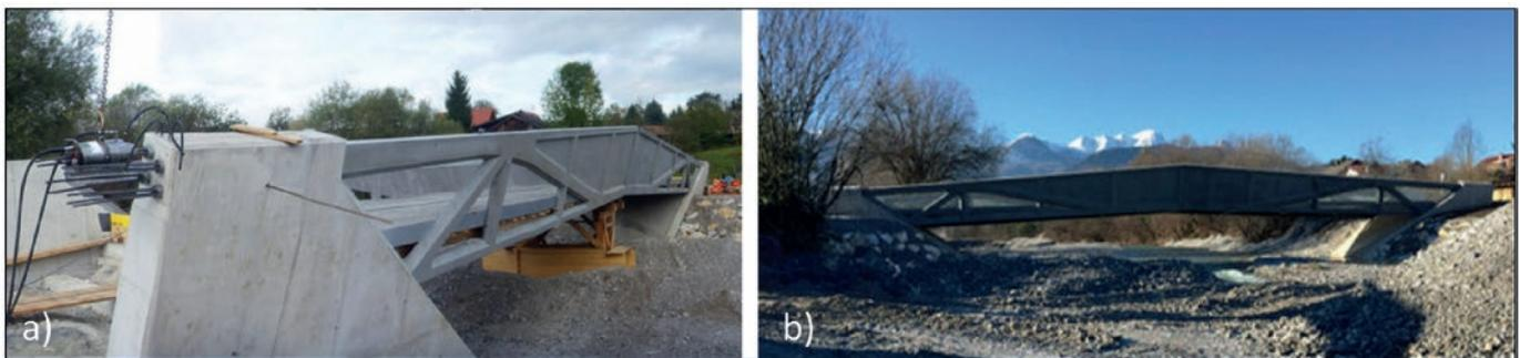
Abb. 9: Paulifurtbrücke in Österreich aus [8] a) im Bauzustand, b) im Endzustand
